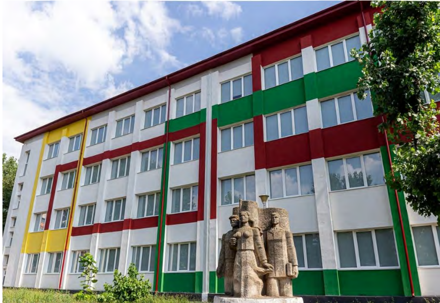
Reabilitarea Colegiului Tehnic „Traian Vuia” – Corp Școală
